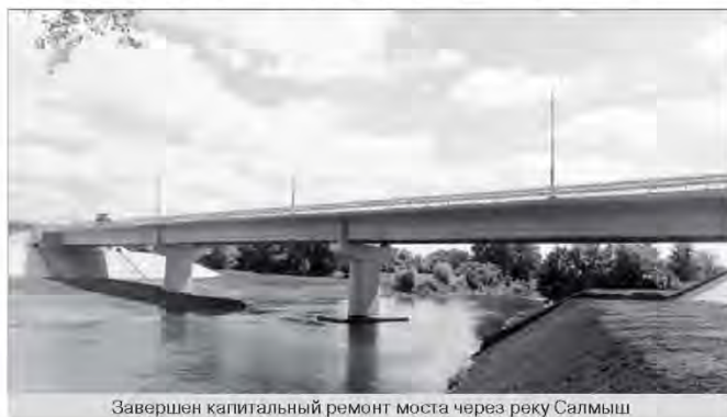
Завершен капитальный ремонт моста через реку Салмыш
